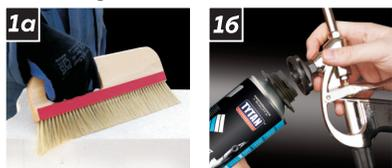
**1. Подготовка:** Очистить поверхность блока от пыли, которая может уменьшить адгезионную способность клея. Тщательно встряхивать баллон в течение 30 секунд, затем навинтить на него пистолет.
